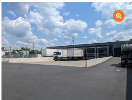
LKW Rampen an der neuen Kommissionierhalle
