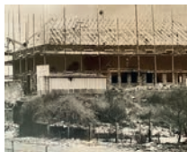
Loni-Übler-Heim im Bau ©AWO Nürnberg
