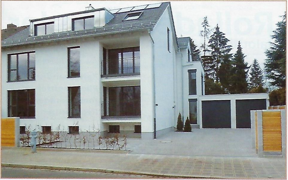
Schicker Neu- und Anbau Haselnussweg
