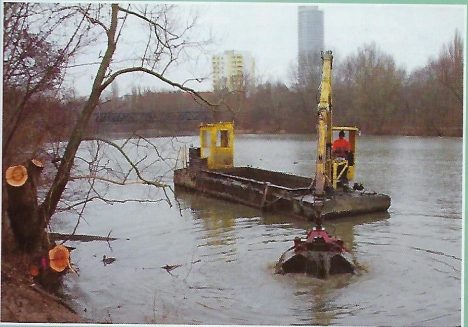
Versuch: Nassbaggerung (Frühjahr 2012)
