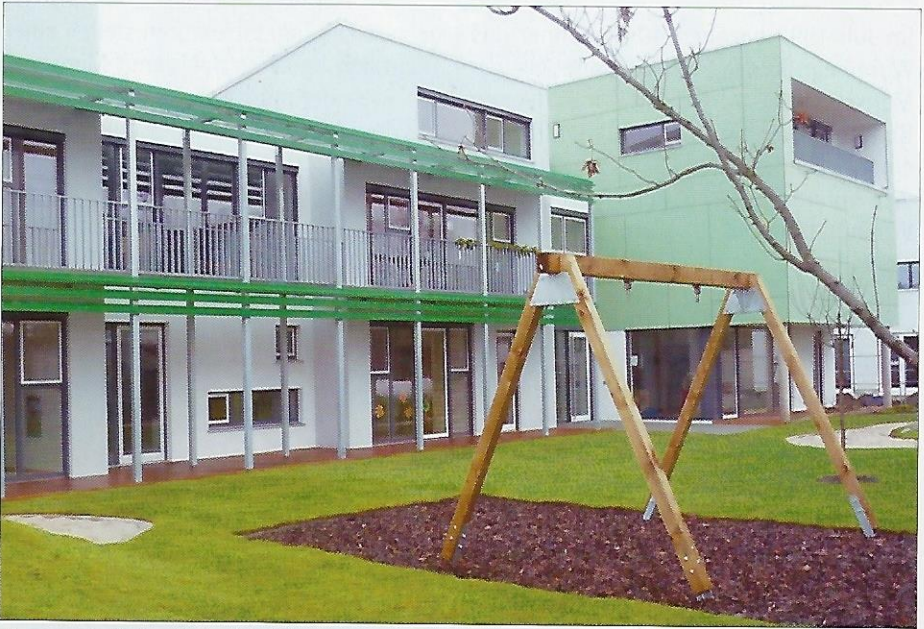
Dagmarstraße bereits im Betrieb.
