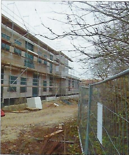
Ostendstraße und MarthasträÙe im Rohbau.
