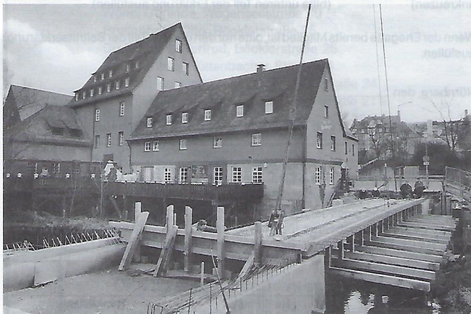
„Neubau der alten Flußbrücke“.
