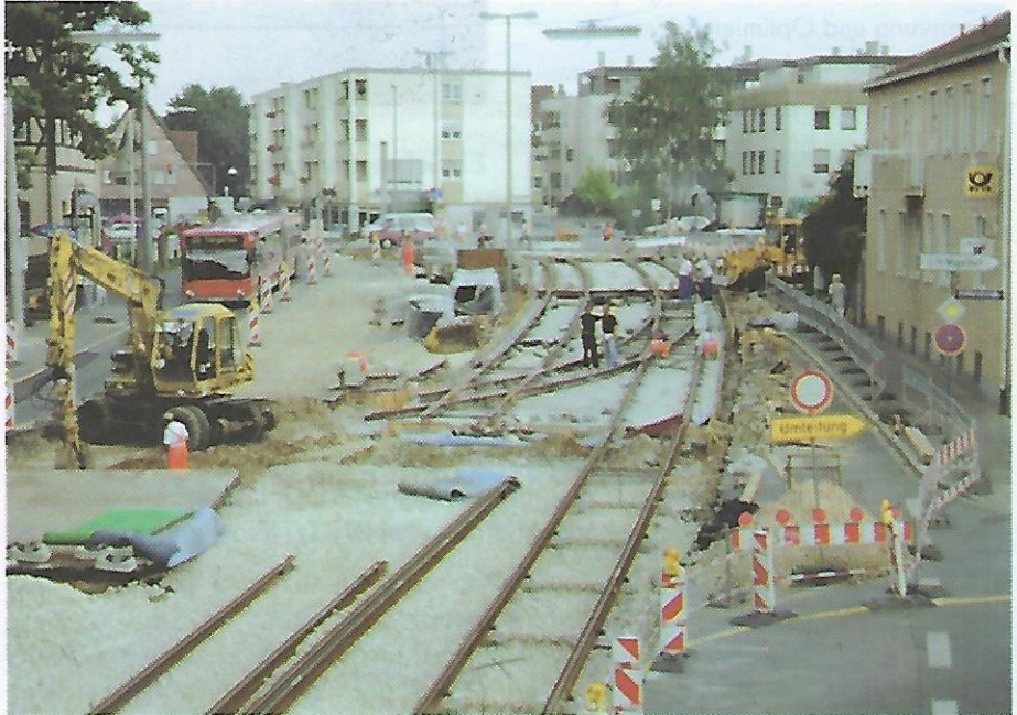
Der Sommer 99 in Mögeldorf war geprägt von den Umbaumaßnahmen am Mögeldorfer Plärrer. Die Aufnahme zeigt den Umfang der Bauarbeiten Foto: Röhrich
