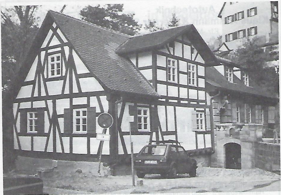
Das Fischergüttelein nach der Renovierung im Oktober 1989.
