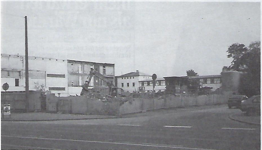
Abriß Ende September 1990. An dieser Stelle soll die Freiligrathstraße verbreitert werden und ein Parkhaus für das geplante Elektronik-Center entstehen.
