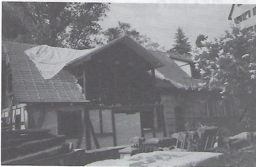
Das Forellengut und das Gästehaus hinter der Satzinger Mühle werden 1988 gründlich umgebaut (Aufnahme Mai 1988).
