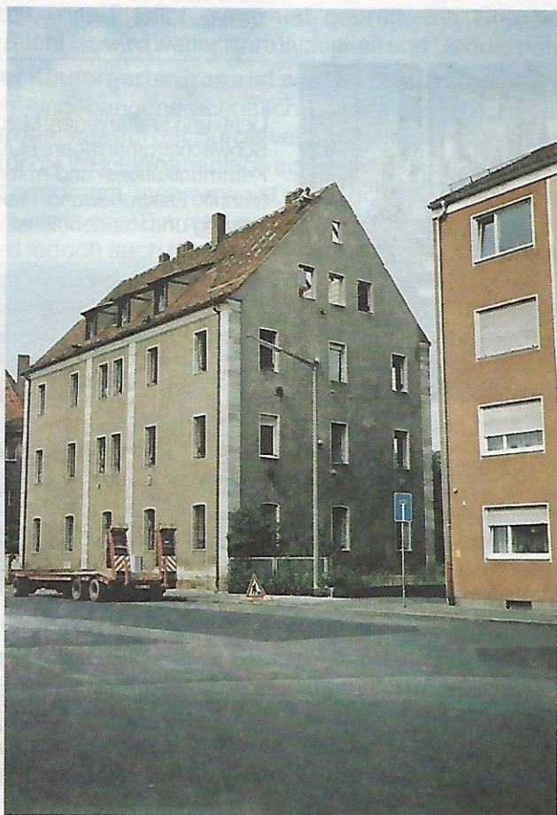
Das Haus Ziegenstraße 31 – der künftige Standort der Diakoniestation Nürnberg-Ost
