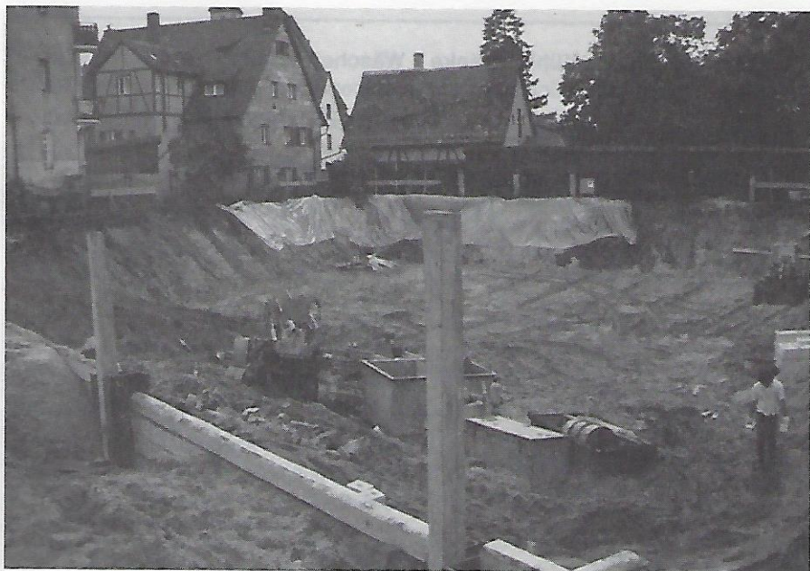
... und jetzt zeigt die Baugrube die große Ausdehnung der Diakoniestation, die hier entstehen soll (Aufnahme vom 6. 9. 1989)..
