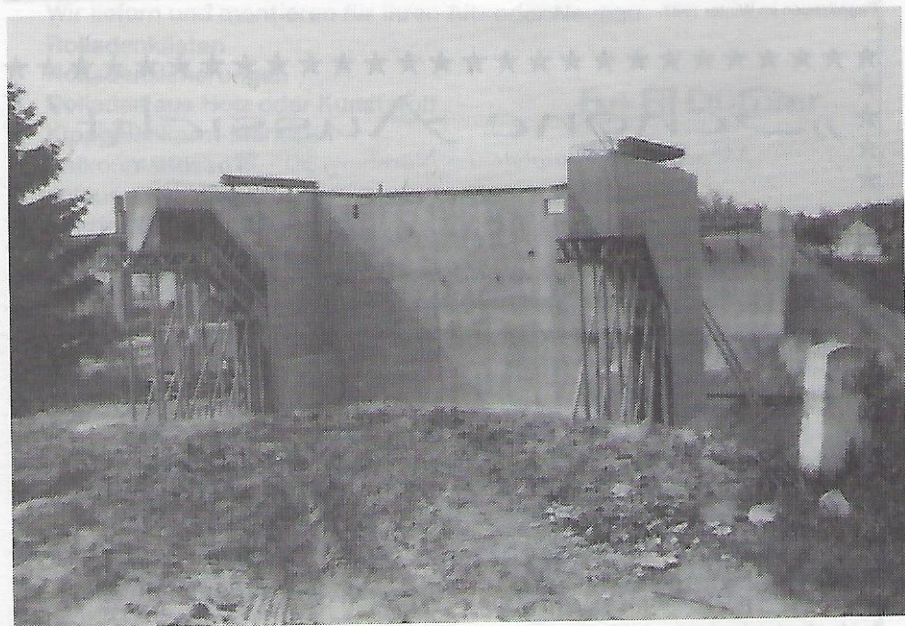
Rehhofbrücke Ende Mai 1987 (Blick nach Norden).
