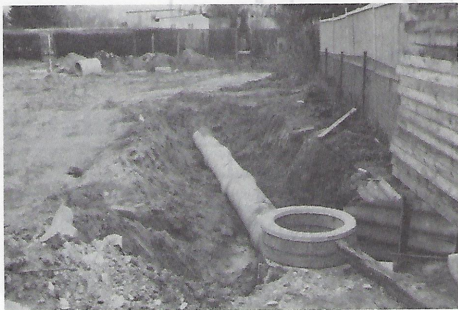
Der Tunnel zum Kiebitzweg wächst weiter. Im Südteil sind umfangreiche Maßnahmen zur Ableitung des Wassers, u. a. vom Egelbach, notwendig. (Bild Anfang Mai 1987).
