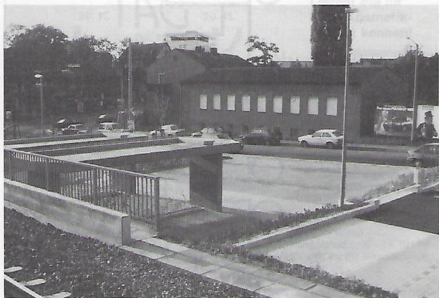
Der neugestaltete Vorplatz am Bahnhof Mögeldorf mit Park- und Stellplätzen für Autos und Fahrräder.
