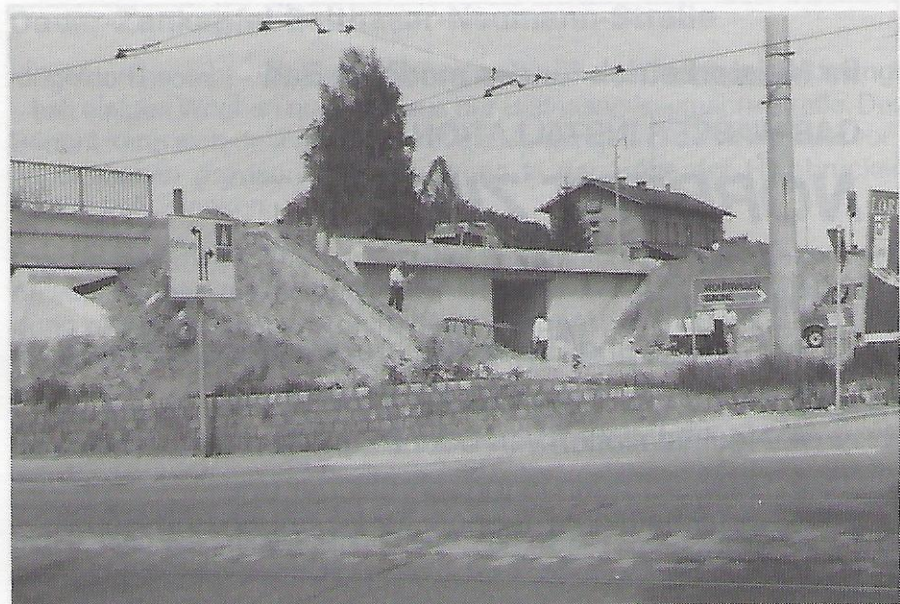
Der Beton an der Südseite des Durchganges wird „verschönt“.
