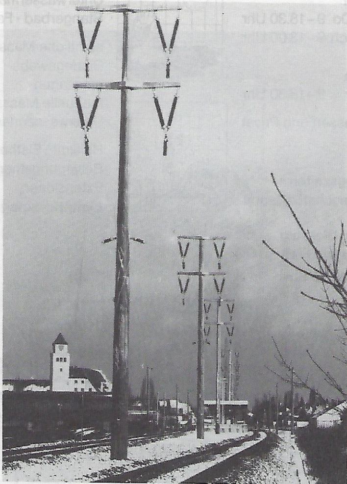
Der S-Bahn-Bau schreitet voran
