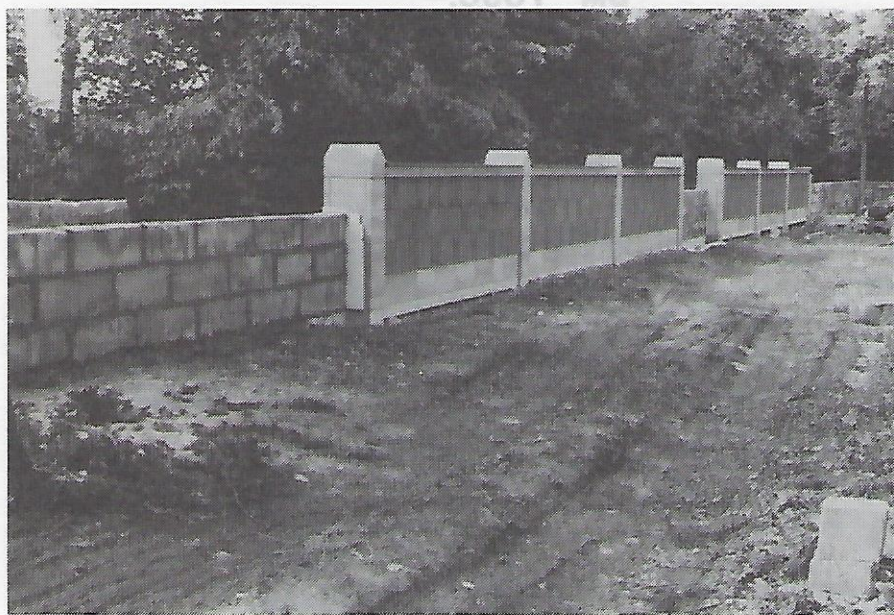
Ende Oktober 1985 ist die Urnenanlage fertig und die alte Mauer versetzt. 252 Urnennischen sind entstanden.
