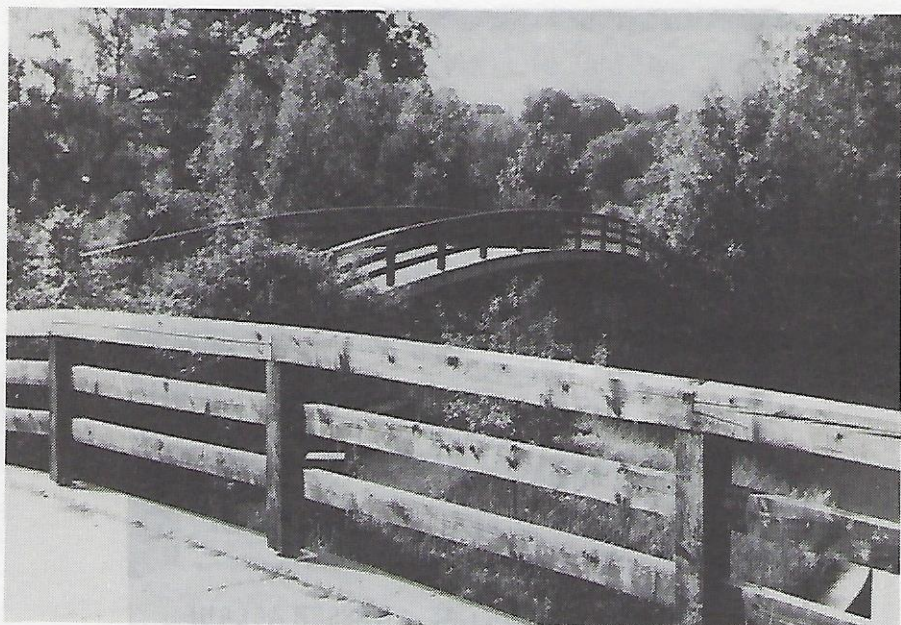
Hinter der Satzinger Mühle (ca. 100 m) wurden 2 elegant geschwungene Betonbrücken errichtet, an denen der Leo-Beyer-Weg beginnt.
