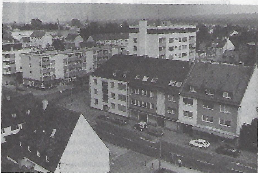
Der Komplex Mögeldorfer Hauptstraße 34 – 36 entstand im Zuge der Straßenverbreiterung nach 1960.
