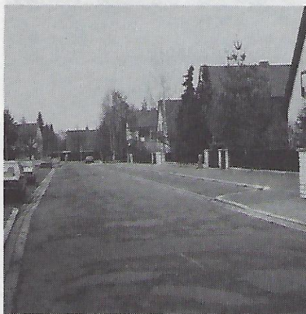
Im Mittelteil des Jasminweges sind großzügige Parkbuchten angelegt.
