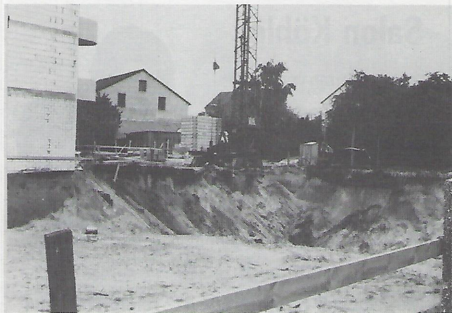
Im Juni 84 war das Haus schon abgerissen und die Baugrube für den Neubau ausgehoben.
