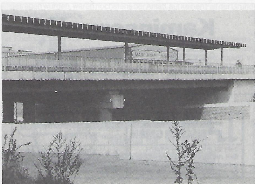
Seit August 1984 nimmt der erste S-Bahnhof in Mögeldorf Form an (Cheruserstraße).
