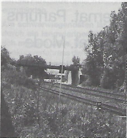
Die alte Prutzbrücke muß der S-Bahn weichen.
