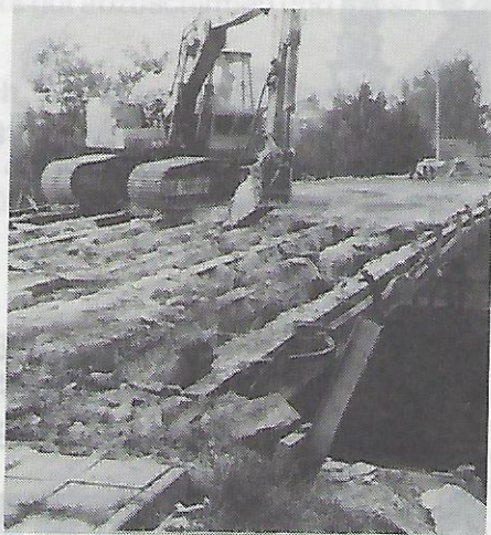
Die Abbrucharbeiten gingen schnell vorstatten.
