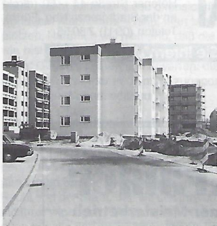
Durch diese modernen Eigentumswohnungen erhielt der Bürgweg im Jahre 1982 ein neues Gesicht.
