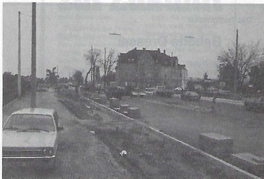
Kreuzung Laufamholzstraße – Prutzstraße; eine großausgebaute Kreuzung mit Insel und Ampelanlage entsteht.
