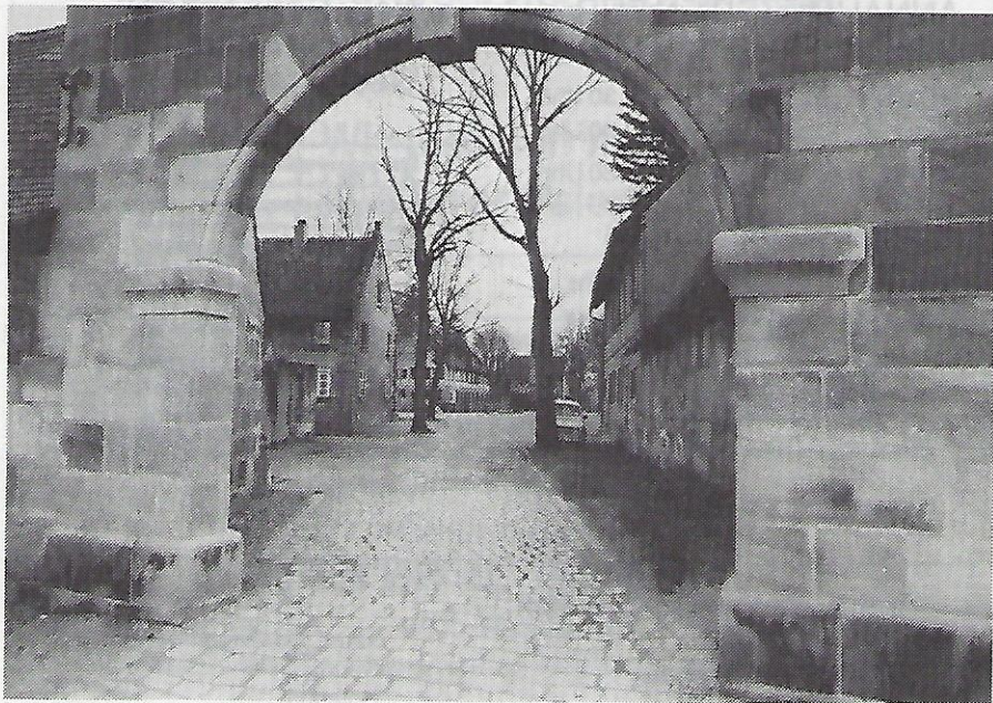
Hammer, Siedlung im Pegnitzgrund
