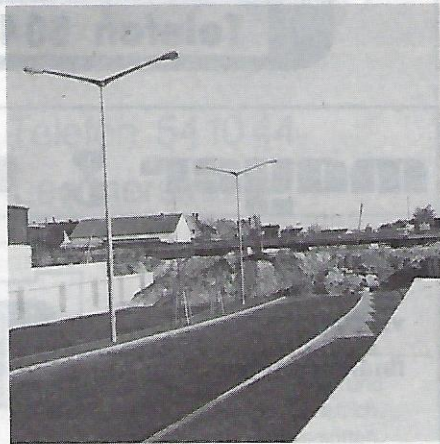
Auf dem Bild ist der großzügige 4-spurige Ausbau der Cheruskerstraße, der in den Jahren 1980–82 vorgenommen wurde, zu erkennen. Die Unterführung unter die Bahnlinie ist noch nicht vollendet.
